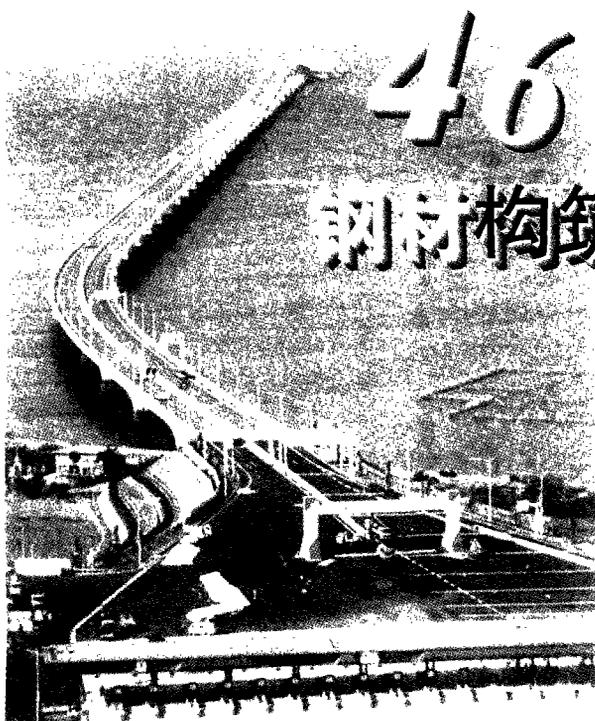
的海底世界。浮岛工地使用的钢材包括钢制套管、钢外壳沉箱、钢管楔板以及钢管樁桩共计 3.5 万 t，工程采用盾构掘进法，使用了 8 台直径为 14.14 m，重达 0.32 万 t 的世界最大级盾构掘进机从不同方向分别掘进，工程中运用了全球卫星定位系统及激光等先进技术。
