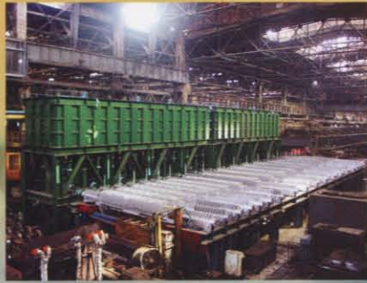
中心承建的舞阳钢铁公司控轧控冷生产线
