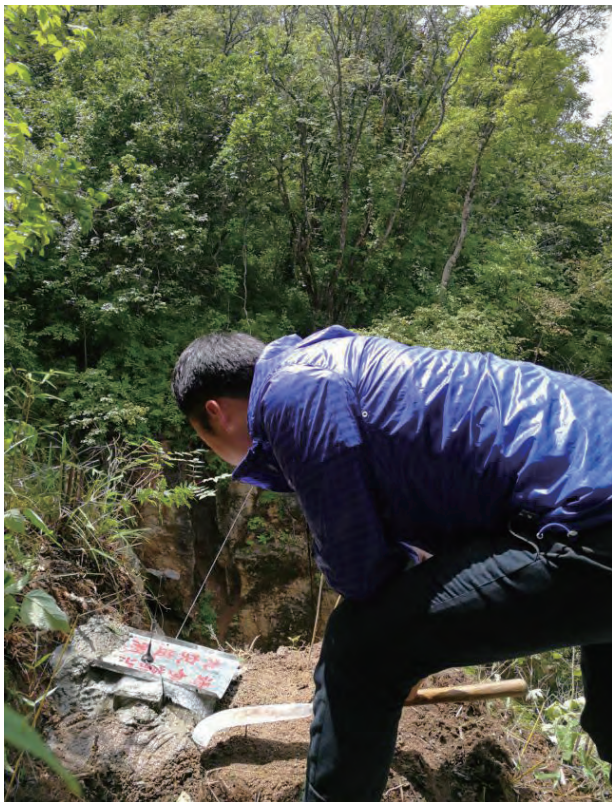
图5 拉线式位移计施工图
