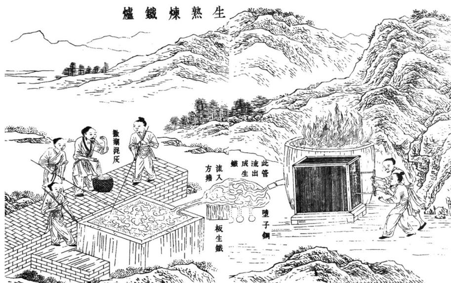
图4 《天工开物》记载的生熟炼铁炉<sup>[7]</sup>
